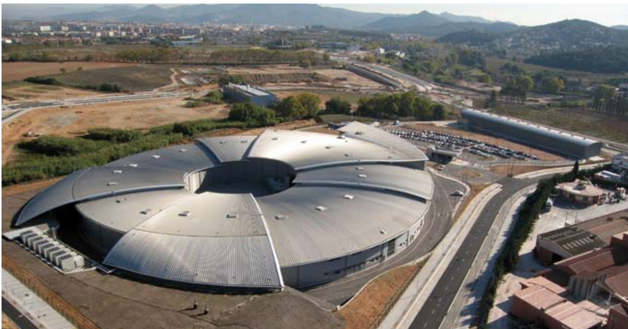
L'edifici que acull el Sincrotró, acabat a finals del 2009, és una construcció de gran complexitat tècnica perquè requereix estabilitat mecànica, control de la temperatura i qualitat del subministrament elèctric. L'operativitat completa de la instal·lació està prevista que culmini el 2011.
